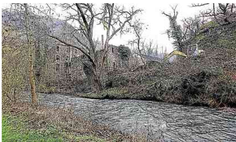
Viele Moselkerner fragen sich, was rund um die alte Wollfabrik geschieht. Die Behörden konnten oder wollten hierzu bisher keine Auskunft erteilen. Es deutet jedoch vieles darauf hin, dass an dem 500 Meter langen Turbinenkanal gearbeitet wird, der die Fabrik mit Energie versorgt. Auch oberhalb der ungenutzten Industrieanlage wird am Wehr neben einer Fischtrappe Erdreich bewegt. Beobachter bezweifeln, dass es sich nur um Instandsetzungsarbeiten handelt.
